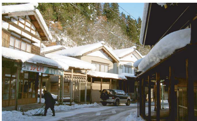
▲ 栃尾表町は約300mにわたって冬場の歩行空間を確保するための「雁木」が連なり、独特の街並みをつくりだしている。
