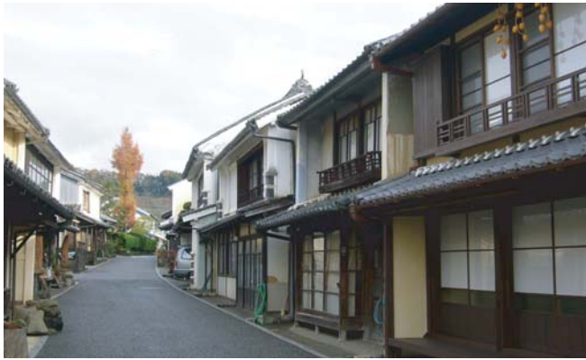
▲八日市地区を南側から望む。緩やかに曲がった街道に沿って平入りの町家が並ぶ。路面は、街なみ環境整備事業で整備した透水性の舗装。
