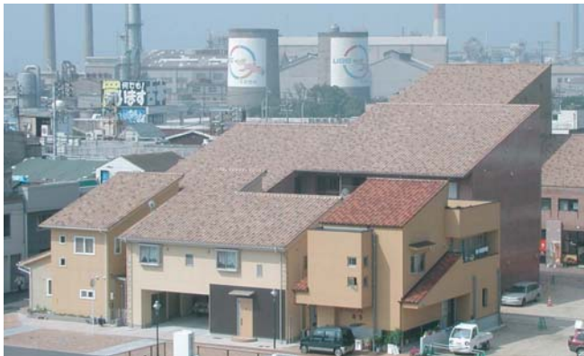
▲ 街づくり協定により屋根材を同一の瓦製品とし、3.5寸勾配北下がり片流れ屋根で統一されている。
