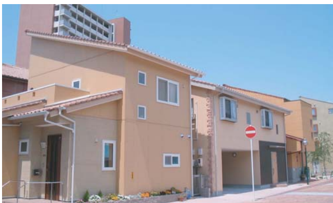
▲ 街づくり協定により外壁は、土系の色(アースカラー)で統一されている。
