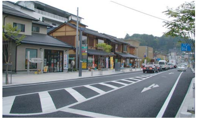
▲屋根を街路に面して平入りに揃えることにより、家並みの連担性を強調し商店街の統一を図っている。
