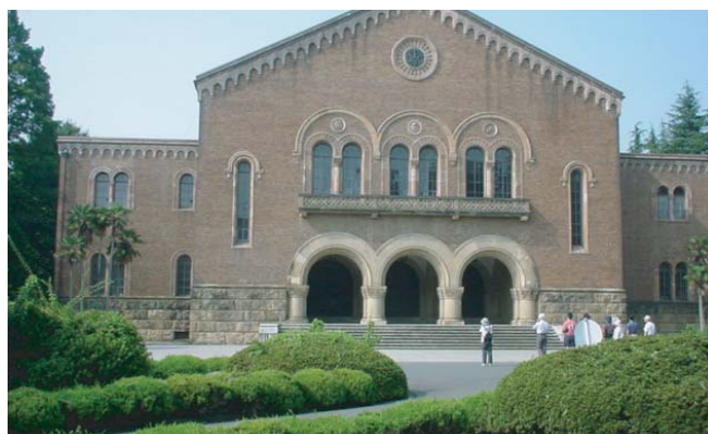
▲大学通りの両側には一橋大学が位置し、国の登録有形文化財である兼松講堂をはじめ歴史的な建造物が存在する。
