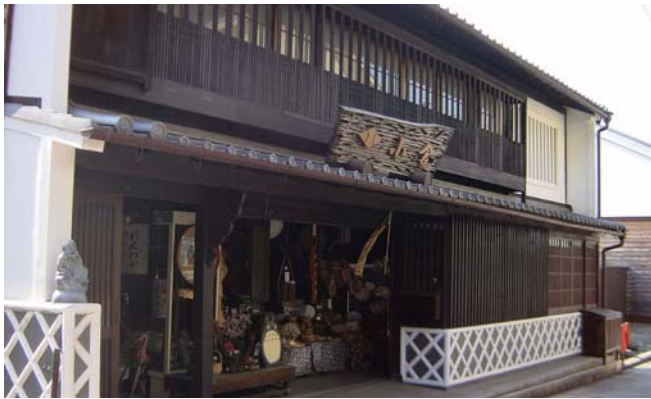
▲保全対象地区にある金物店。明治～大正～昭和初期にかけての最盛期をほうふつとさせる外観にあわせて看板も古めかしいデザインに変更した。
