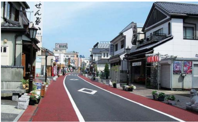
▲沿道建物のセットバックが完了した区間では、電線類の地中化やストリートファニチャーの設置等により、快適な歩行と青空が広がる。
