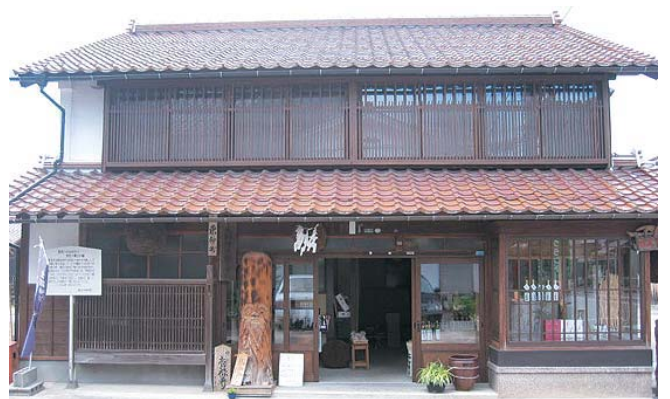
▲明治中期頃の建立と推定される江戸期の形式から本二階建てへと変化していく、当時の町屋建築である。現在酒販店として使用されており、隣の土蔵は「赤瓦三号館」として利用される。
