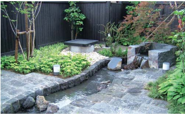
▲簡易水道の水源池を市が購入し、暗渠であった四ノ宮川を上下の水路とし、上部には湧水の綺麗な水を流した。近隣住民が清掃活動を行っている。
