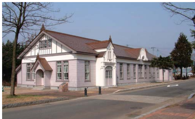
▲ 鉱山従業員子弟の幼児教育機関であった天使館。昭和7年竣工で、平成15年国登録有形文化財指定。
