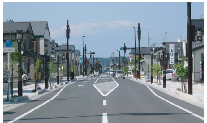
▲通町南町通り線の起点(南)から終点(北)を望む。電線類ソフト地中化によりすっきりとしたまちなみが形成されている。
