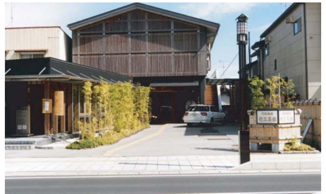
▲空き店舗だったパチンコ店を改修して整備された岩出山町竹工芸館。
