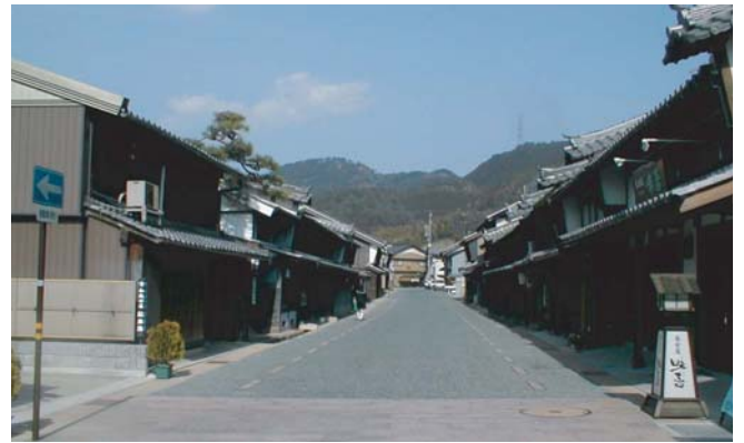
▲一番町通り、建物のファサードが整然とし、良好な景観形成がなされている。
