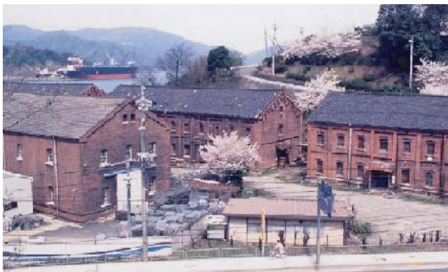
▲ 舞鶴湾岸に立ち並ぶ12棟の赤煉瓦建造物群。
