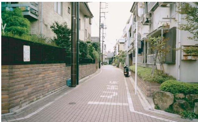
▲ 整備地区の代表的な町並み景観。沿道緑化、カラー電柱、架空電線整理、インターロッキング舗装。
