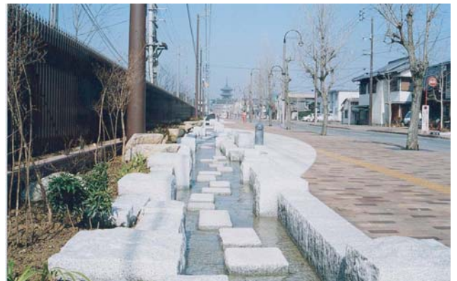
▲市道大門通り線から五重塔を望む。水路は二重構造で下部は従来の排水路（暗渠）、上部は地下水を循環するせせらぎ水路。
