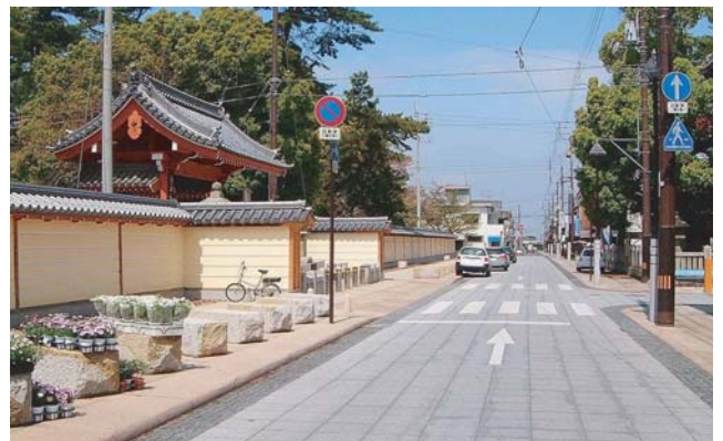
▲歴史空間軸：鎌倉通り線。歩車道すべてを石張り、歩道上に石を配置。白壁にはライトアップをして夜間景観を演出。
