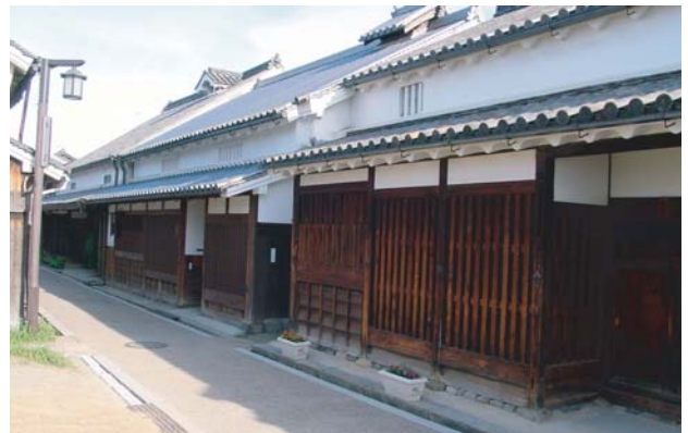
▲1階「みせ みせおく」部分に取り付けられた格子。
