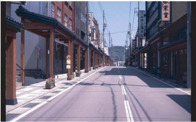
▲「寺の街並み事業」が完了し復活した雁木。雁木の設計、舗装の色、電柱の配置等に住民の意見を反映。通りを横切る電線は極力少なくし、沿道に花を飾り、潤いある景観を創出。
