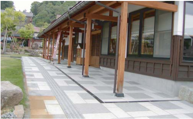
▲雪と寺の町公園の休憩処。土蔵を移築、改装して整備。寺の町に調和している。
