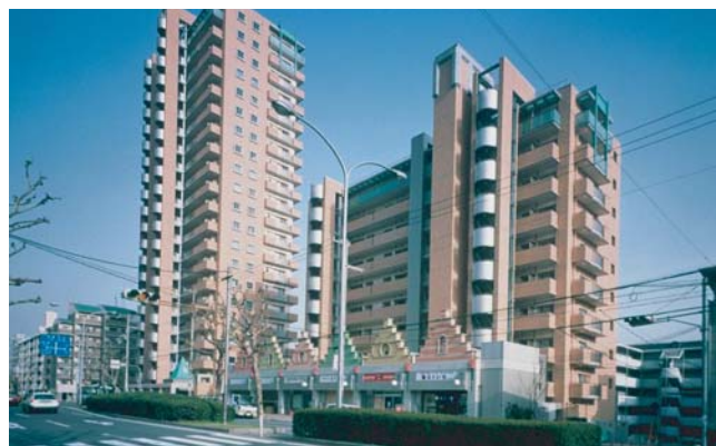
▲ 道路拡幅整備。
