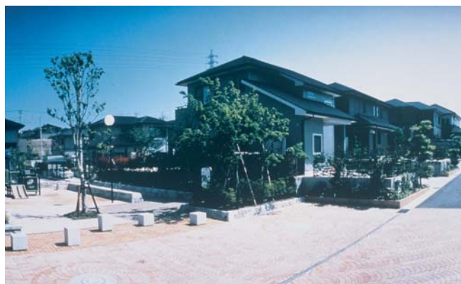
▲ 生活道路とポケットパークの組合せによる「ひろば」的空間が街のアクセントになっている。
