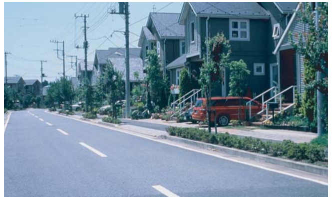
▲ 地区計画に基づく緑豊かなオープン外構により、通称ガーデニング通りと呼ばれる美しい街景を創出。
