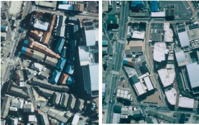
▲（写真左）整備前。老朽建築物が無秩序に建ち並んでいた。 （写真右）整備後。公共施設整備と共同住宅等を建設。
